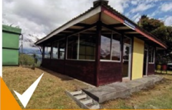
Acondicionamiento de ranchos
