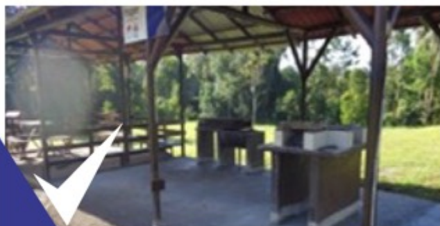
Losa de concreto
