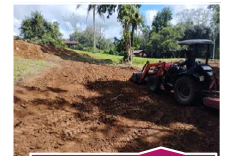
nivelado y limpieza del terreno
